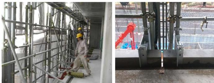
写真1 両重ね継手(ユニット解体) 写真2 片重ね継手(支持)
